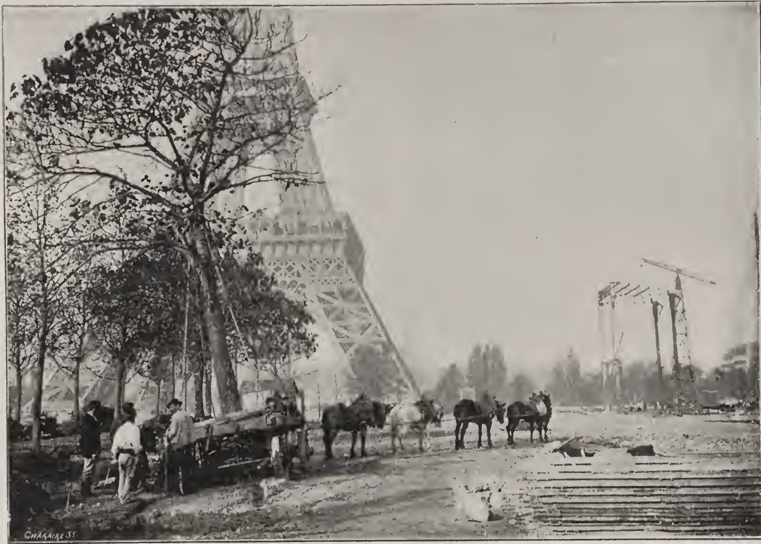
AU CHAMP-DE-MARS. — Déplacement des arbres pour l'ouverture des nouveaux chantiers.
